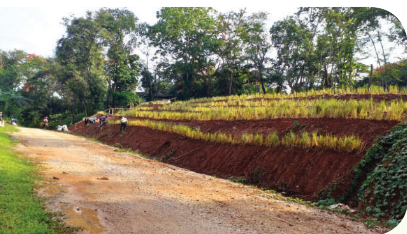
การปลูกหญ้าแฝกป้องกันการพังทลายของหน้าดิน
