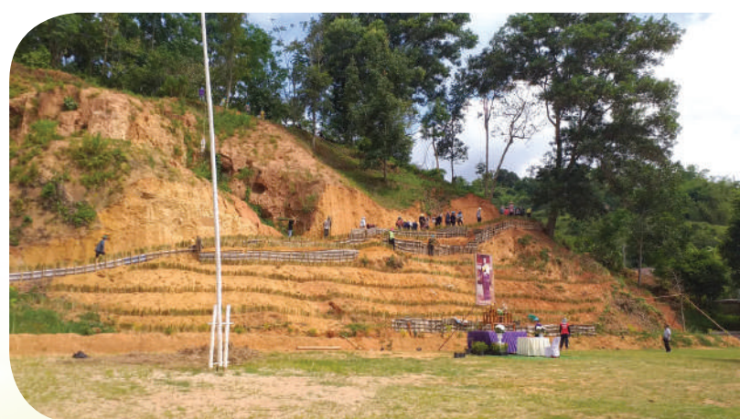
การปลูกหญ้าแฝกป้องกันการพังทลายของหน้าดิน
